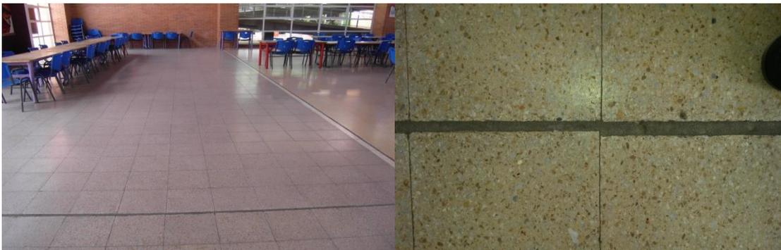
Diferencias del enchape del piso del comedor y errores en los terminados de las juntas de las tabletas.
