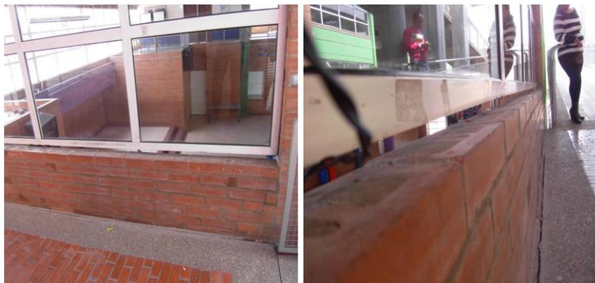
En la foto izquierda se evidencia la luz o separación entre el muro y el marco metálico. En la derecha adicionalmente a la separación, se muestra la fisura entre el muro y el pasillo.
