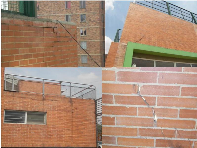
En las fotos superiores, se observa el agrietamiento de la mampostería presentado a lado y lado del sector del bloque del comedor y la cancha. En las fotos inferiores se observan los diferentes tipos de fisuras, incluso con el paso de la luz, presentados en los bloques probablemente a causa de un elevado asentamiento diferencial.
