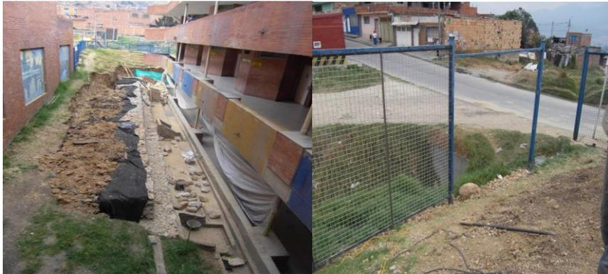
Izq. Obras de estabilización con gaviones. Der. Cambio de malla tipo SED.
