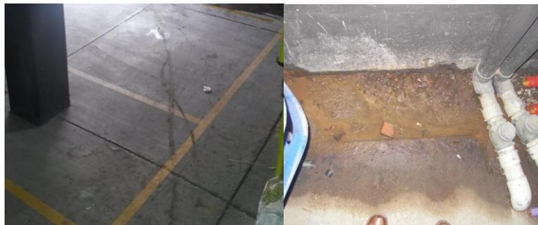
Izquierda: Hundimiento de la columna que ha ocasionado desnivel y fisuras en placa del sótano. Derecha: Agregado grueso a la vista por pérdida de finos y concreto lavados a causa de las evidentes fugas de agua.
