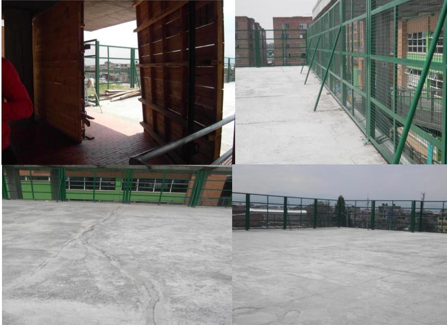
Estado de la cubierta del comedor. Superior: puerta en repisa instalada por el Colegio y tubería de refuerzo de la malla ubicada dentro de la zona del supuesto polideportivo. Posterior: grietas, desniveles y abrasión de la placa de concreto donde no se instaló ninguna cancha.
